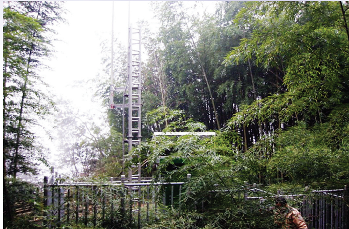
圖3-3 無線電中繼台
