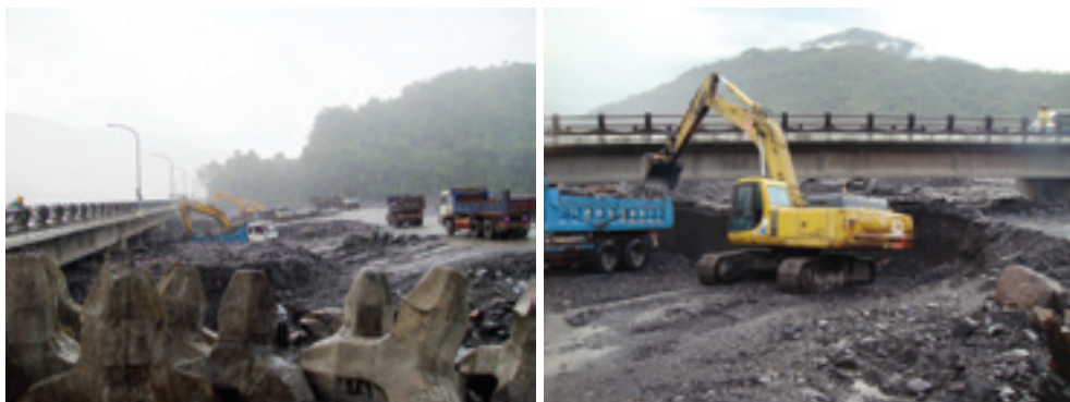
圖3-9 土石流重機械搶修
