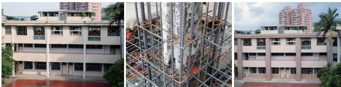
圖7-7 公有建築物耐震擴柱補強
