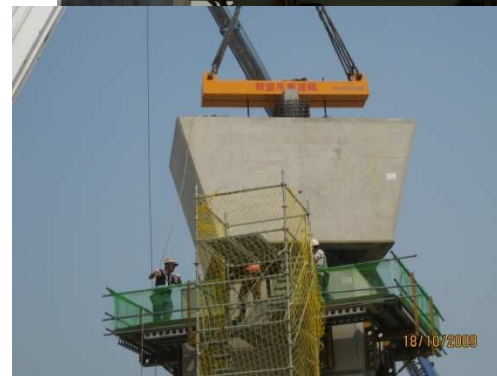
橋柱節塊吊裝作業
