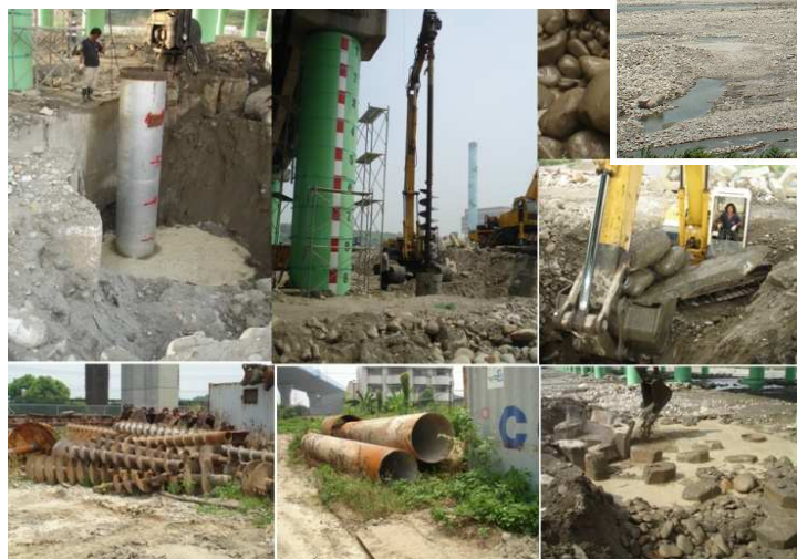
於現地建置橋梁即時監控系統進行實地驗證
