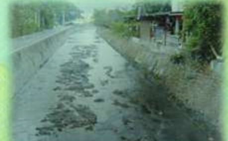
清淤工程施工後
