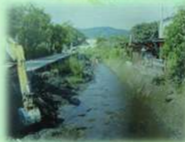
清淤工程施工中
