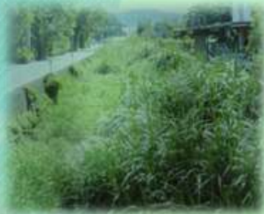
清淤工程施工前
