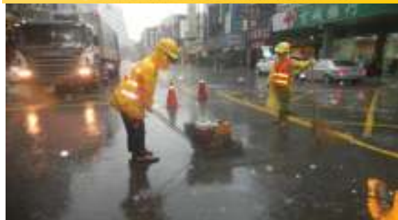
AC廠設置可提升本市道路搶修效率
