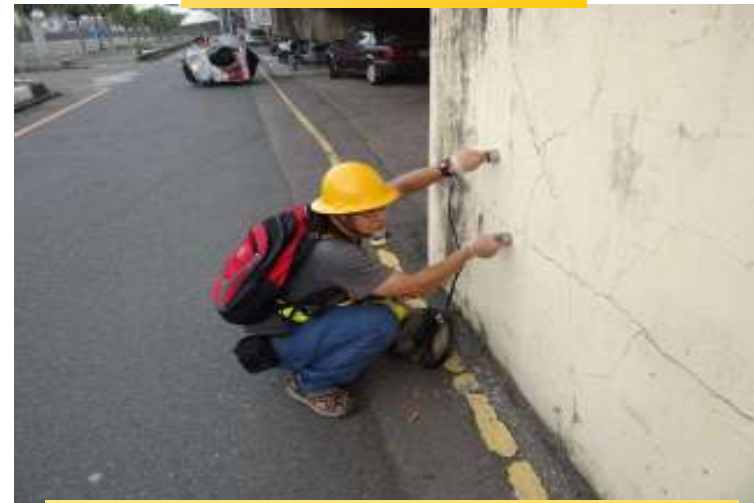
橋梁(含地下道)非破壞性檢測
