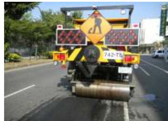
103年新購3合1道路修補車 可即時辦理道路搶修作業
