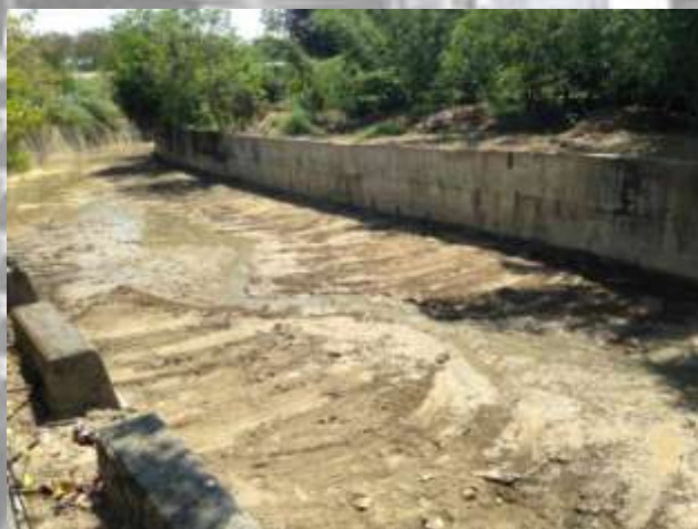
區排清疏完成後
