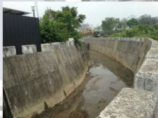
區排清疏情形
