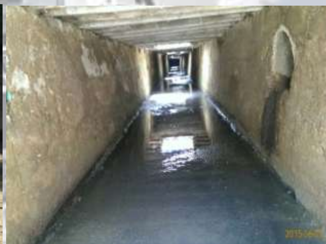
雨水下水道清疏後
