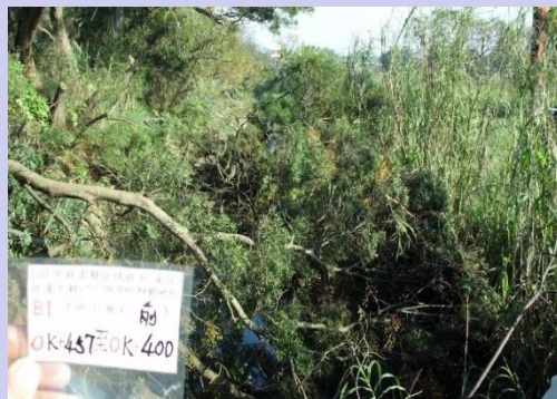
清淤工程施工前照片
