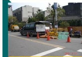
設置工程、勞安告示牌
