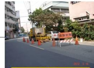
設置交維設施
