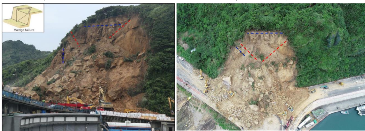
圖 5、崩塌事件之坡面節理面（紅線、藍線）
