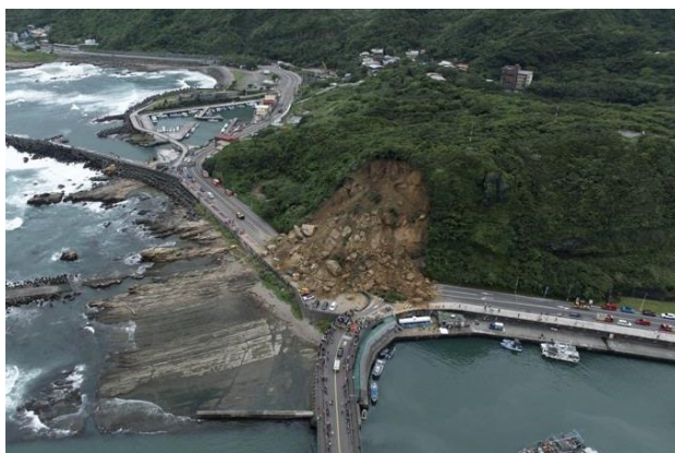
圖1、台2線70K處邊坡發生崩塌 資料來源：基隆市政府
