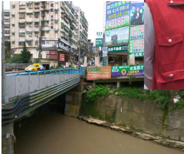
武崙橋不繡鋼防洪牆
