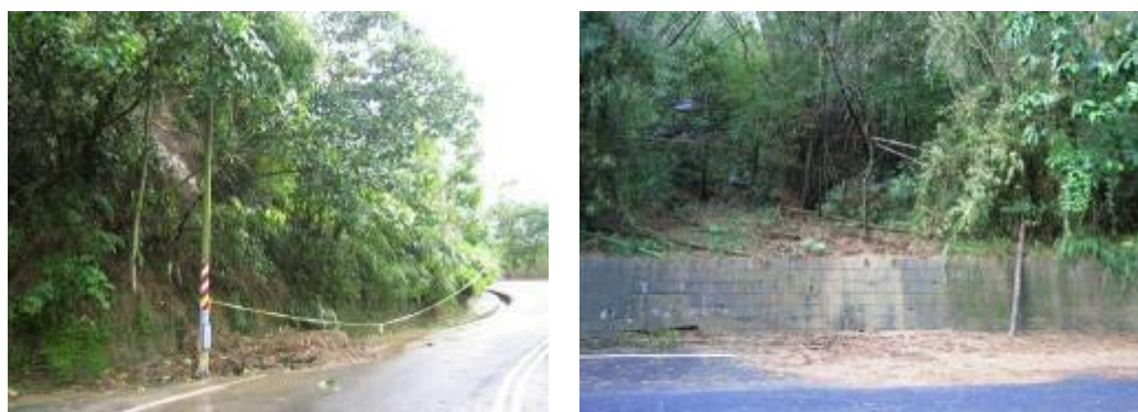
圖 5-9 環潭路週邊小規模淺層崩塌及土砂流出
