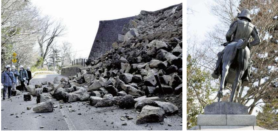
圖 5、文化古蹟損壞情形（左：仙台城遺址石牆倒塌、右：伊達政宗雕像受地震傾斜） 資料來源：CNN、NHK
