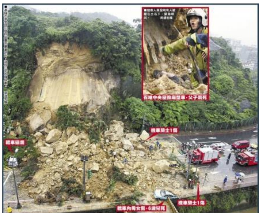
圖 10 民國 96 年 6 月 8 日基隆市安樂區麥金路山崩
