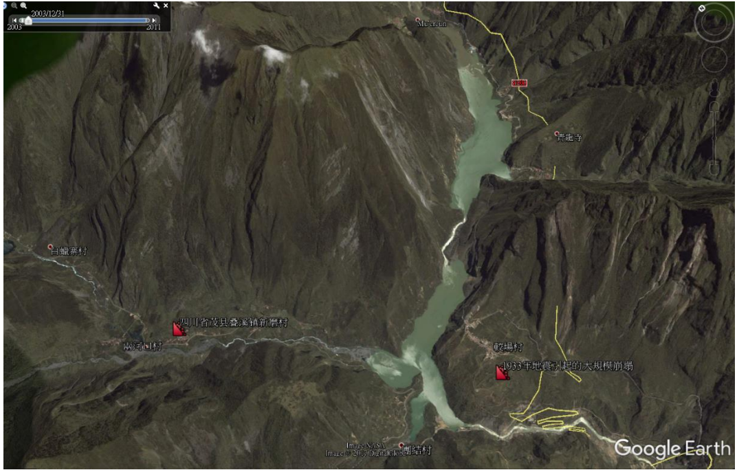
資料來源：國家災害防救科技中心及 Google 圖 6：茂縣新磨村崩塌位置與 1933 年因為地震引起的大規模崩塌 (註：新磨村南側山體於 1993 年曾因規模 7.5 地震，導致大規模崩塌，阻斷河道形成湖泊)
