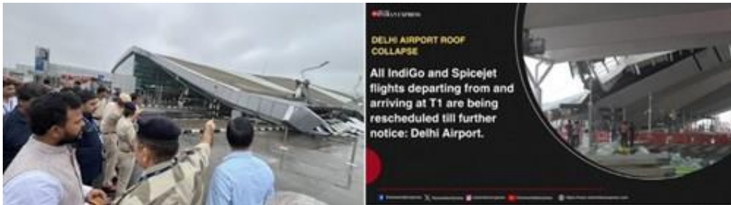
圖4、德里機場因強降雨導致屋頂崩塌
