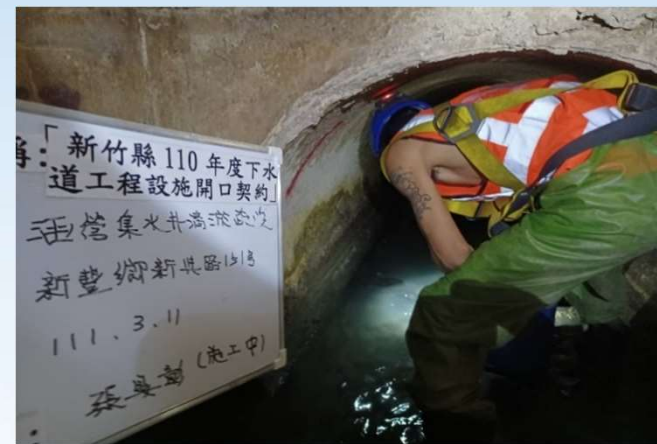
新竹縣新豐鄉新興路151號前雨水下水道清淤施工作業
