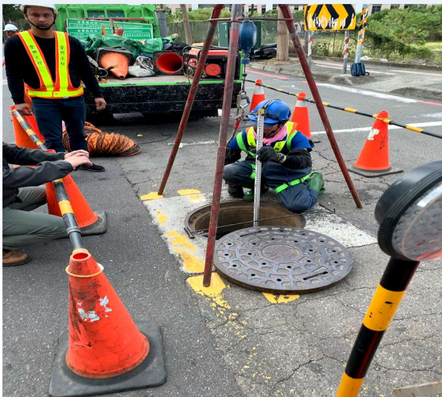
雨水下水道清淤檢查作業(新竹縣竹北市成功十二街與自強五路路口)
