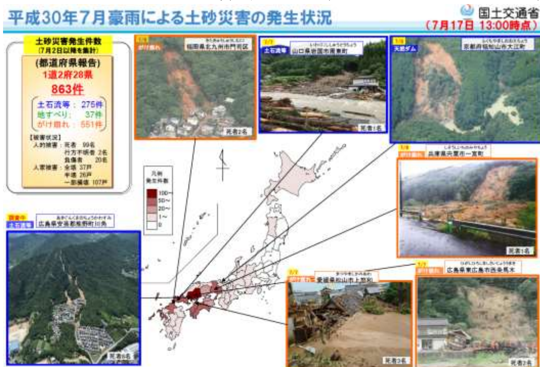
圖 5：國土交通省彙整之坡地災情 資料來源：MILT
