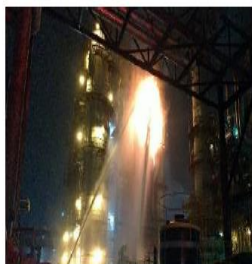
現場洩漏起火燃燒處
