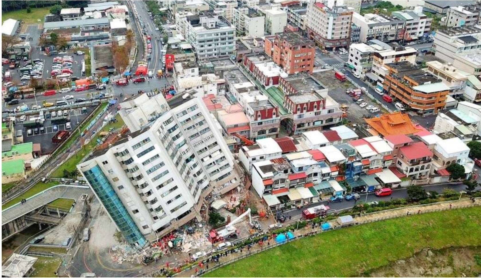
受損的雲門翠堤大樓
