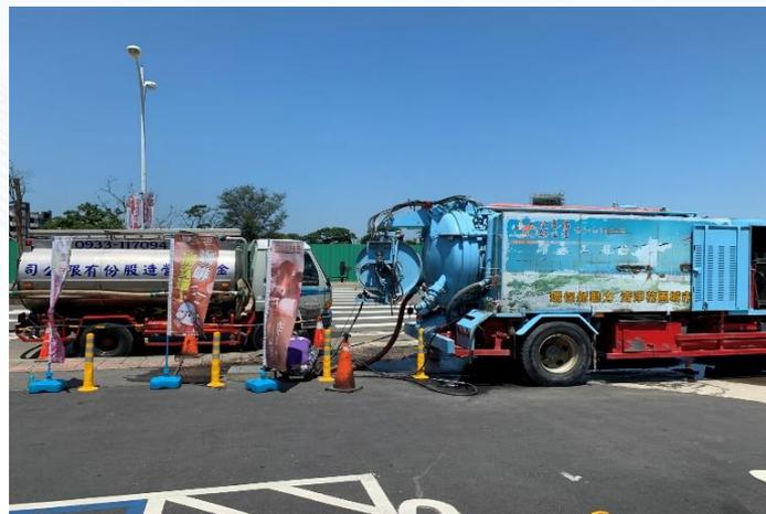
雨水下水道聯通管抽泥車抽除淤積作業
