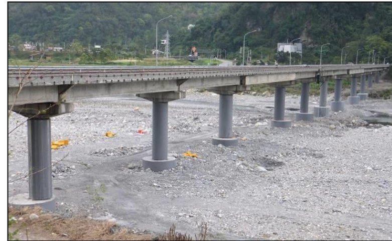
橋墩鋼板包覆
