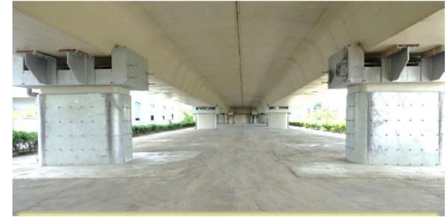
橋墩鋼板包覆及增設止震塊
