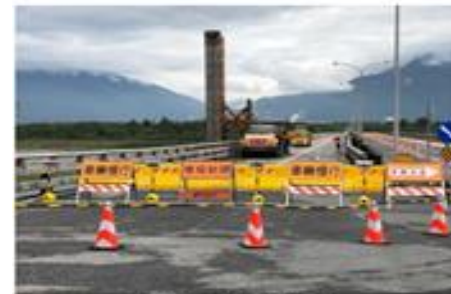
橋檢及封路作業
