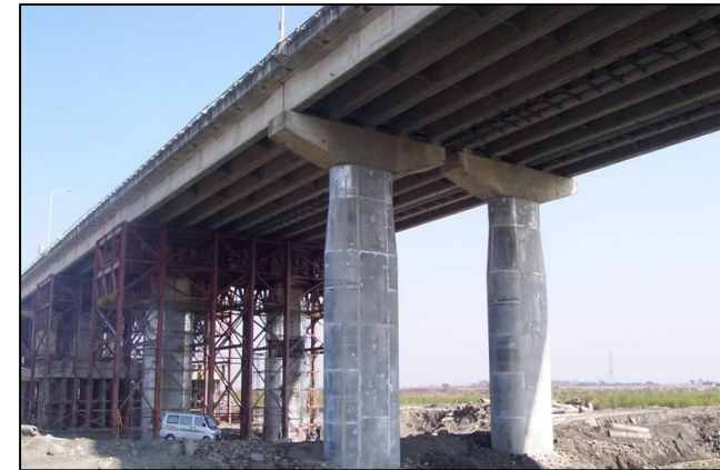
橋墩鋼板包覆
