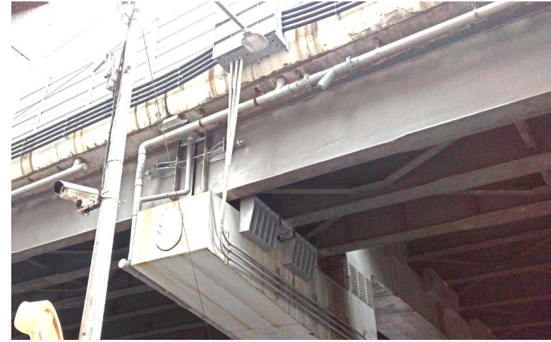
增設鋼製止震塊
