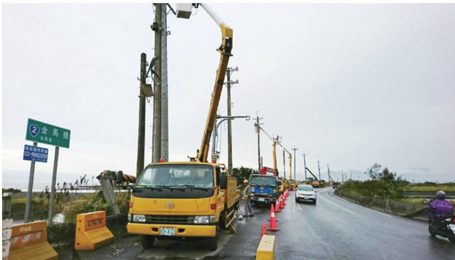
圖2-46 台電公司頭濱#25~38高壓斷桿搶修情形
