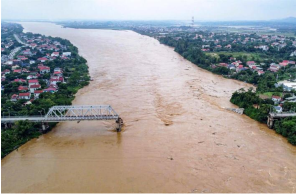
圖 5、越南富壽省峰洲橋發生斷裂
