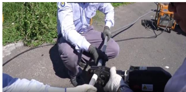
輸電線路實兵演練搶修線路
