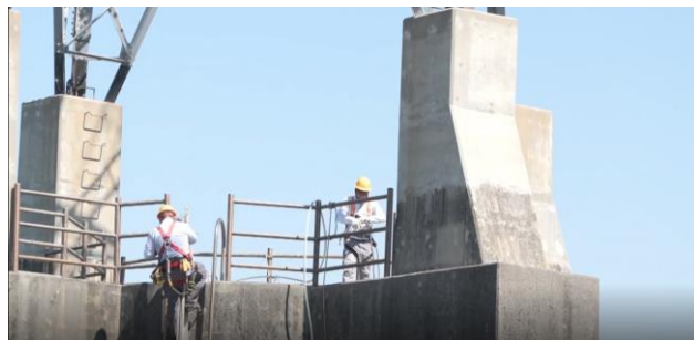
輸電線路實兵演練攀爬鐵塔
