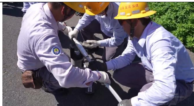
輸電線路實兵演練搶修線路
