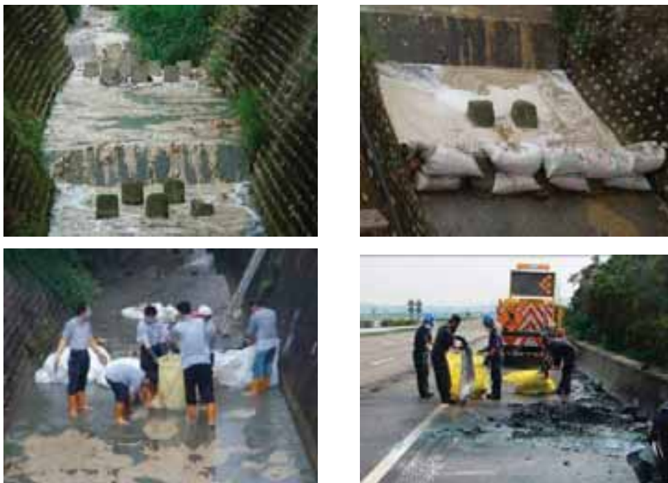
圖2-65：善後復原(廢水圍堵、移除及廢棄物清理) 資料來源：行政院環境保護署
