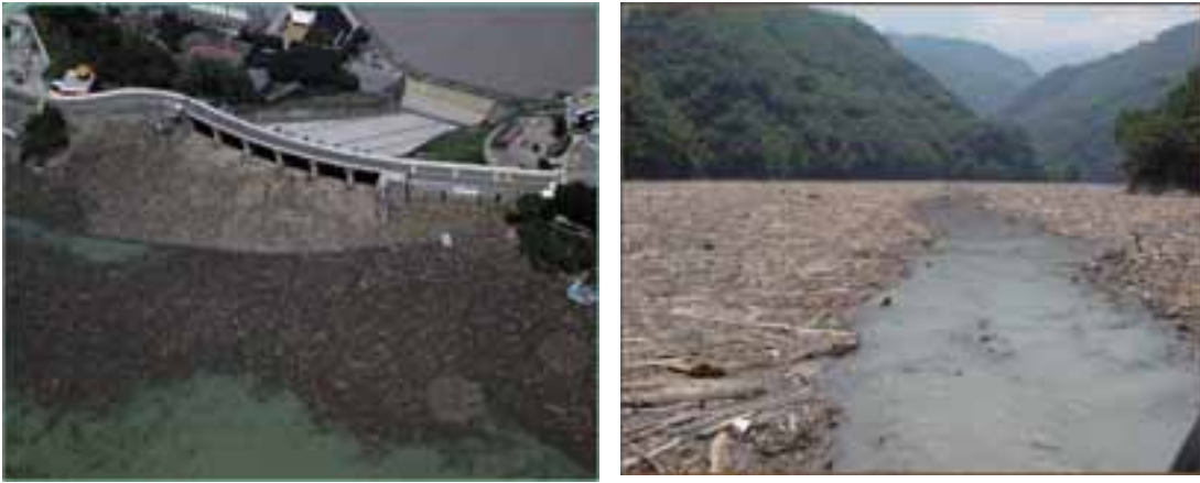
圖2-4：石門水庫溢洪道漂流木淤塞照片 資料來源：石門水庫及其集水區整治計畫網站
