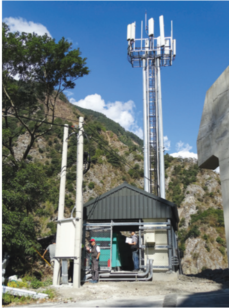
圖4-3 臺中市和平區（壩新段0088-0000地號）定點式防救災行動通訊平臺
