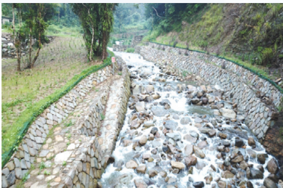
圖4-12 新店區平廣溪國有林地土石流1期防砂工程
