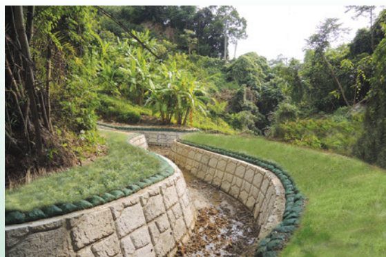
圖4-6 臺中市霧峰區樟公廟旁坑溝整治二期工程
