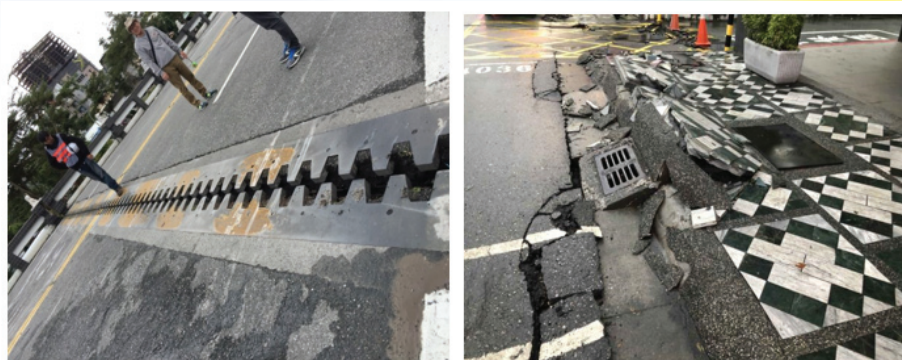
花蓮市尚志橋、中正路(中山路及明禮路段)人行道暨排水溝復建工程
