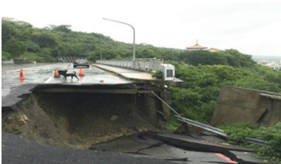
高雄市鼓山區萬壽山橋引道災修重建工程
