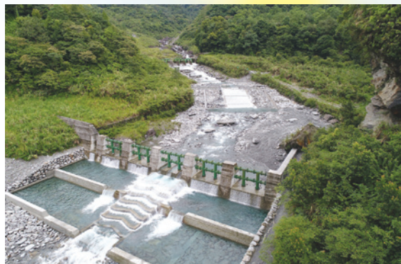
圖4-8 花蓮縣嘉農溪9號梳子壩周邊加強工程
