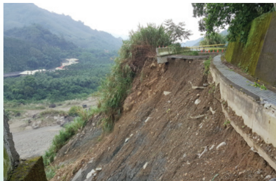
南投縣竹山鎮桶頭里小旗巷(舊投57線)災修復建工程
