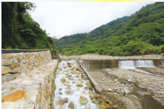
圖4-13 臺中市和平區東卯溪下游治理工程
