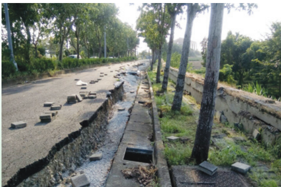
台南市歸仁區歸仁二路災害復建工程
