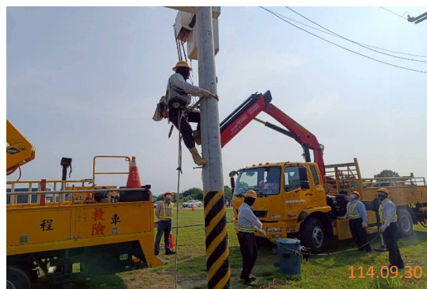
台電公司進行電力搶修作業-變壓器更換(4)
