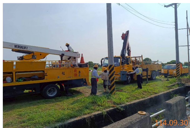
台電公司進行電力搶修作業-施工說明
