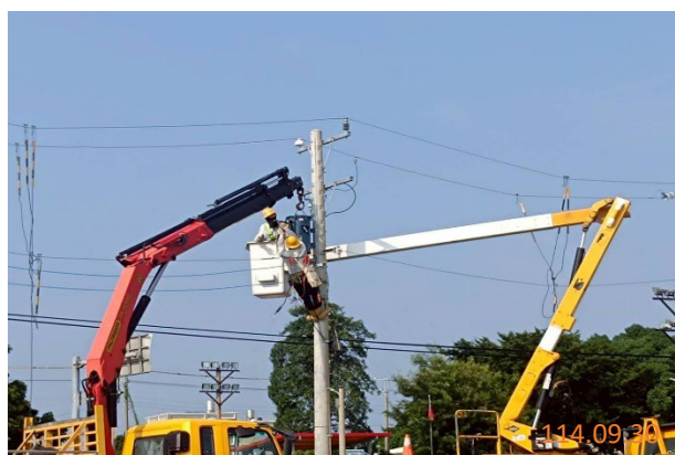
台電公司進行電力搶修作業-變壓器更換(1)
