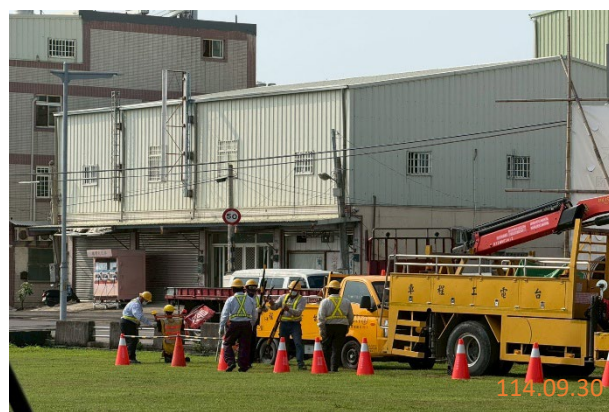
台電公司進行電力搶修作業-變壓器更換(2)
