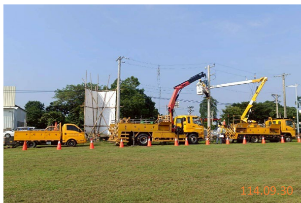
台電公司進行電力搶修作業-變壓器更換(3)
