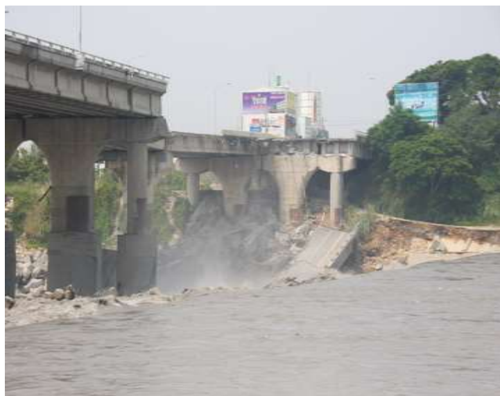
圖 1-3-2 辛樂克颱風后豐斷橋
