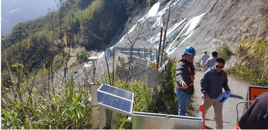
圖 6 崩塌地頭部裂縫鋪設帆布情形
