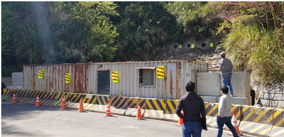
圖 5 攔阻崩塌發生時下移土砂之貨櫃放置情形
