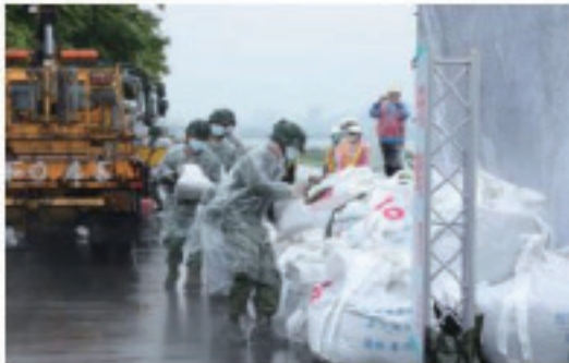
破堤圍堵作業
