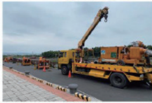
大型移動式抽水機抽水作業
