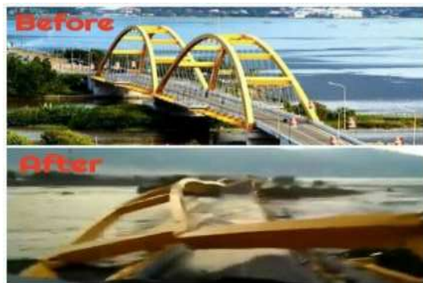
圖 6：橋梁因河道陷落而結構斷裂、毀損情形
