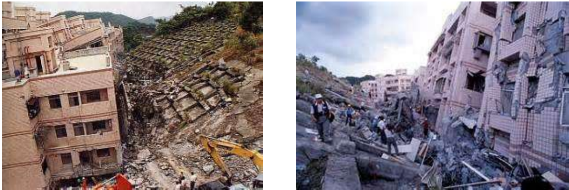
圖 5 汐止大郡倒塌現場照片
