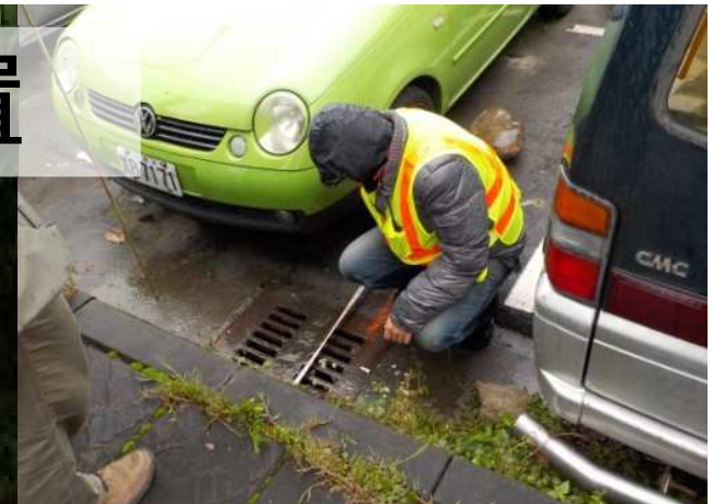
雨水下水道測量及縱走檢核
