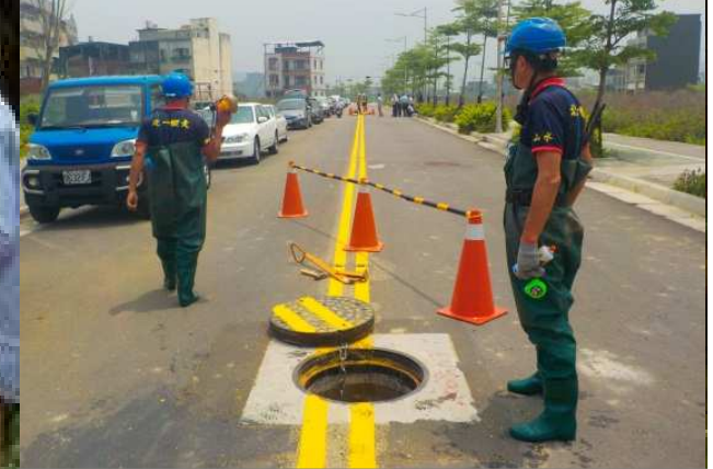
雨水下水道測量及縱走檢核
