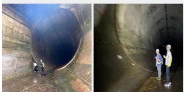
十河分署 員山分洪設施巡查情形
