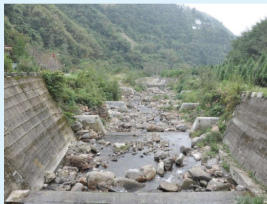
錦泰地區1-300號土石災害復育工程
