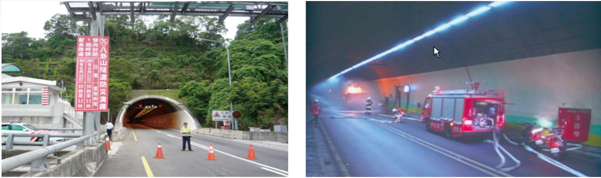
圖2-38臺76線八卦山隧道災害演練照片
