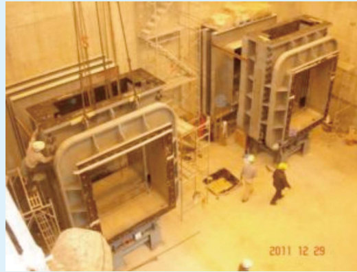
電廠防淤1期工程閘門安裝
