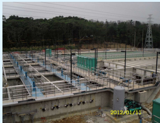
龍潭淨水場擴建淨水設施施工照片
