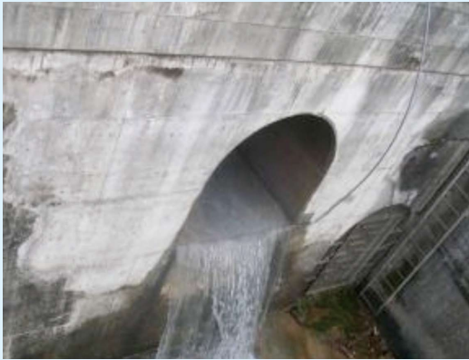
永久河道放水口放流照片
