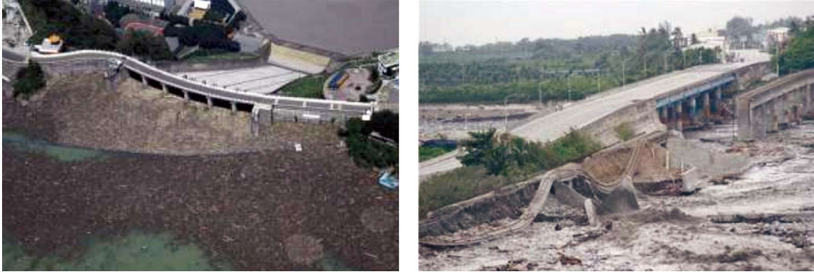
圖3-11 (左) 漂流木阻塞水庫；(右) 洪水夾雜土砂毀損橋梁
