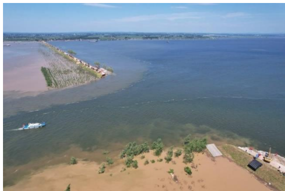
圖 2、洞庭湖潰堤現場
