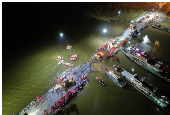
圖 3、7 月 8 日晚間完成封堵潰堤的「合龍」工作
