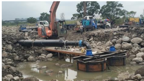
圖 14 油羅溪緊急抽水施工照片
