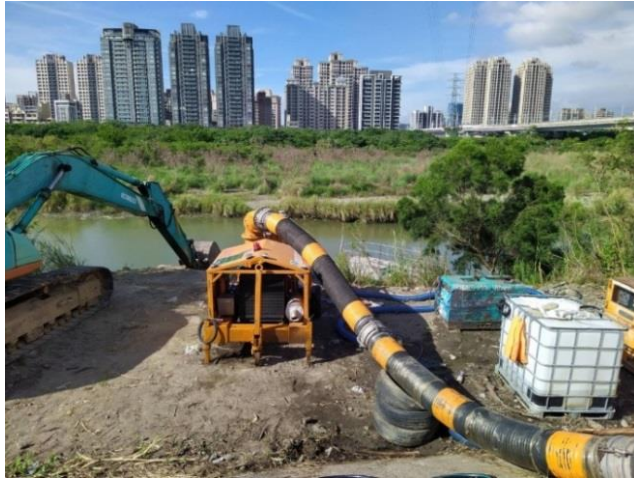
圖 15 隆恩堰下游緊急抽水情形
