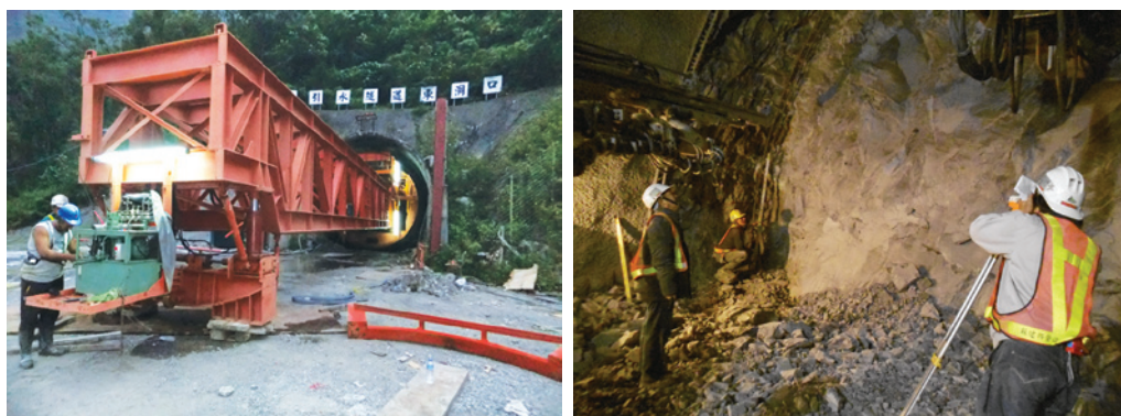
圖5-6 水庫更新改善區清淤及防淤改善工程
