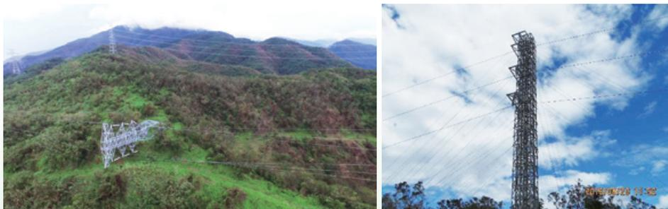
圖2-35 核三~楓港線鐵塔倒塌及新設臨時角鋼桿穩定供電
