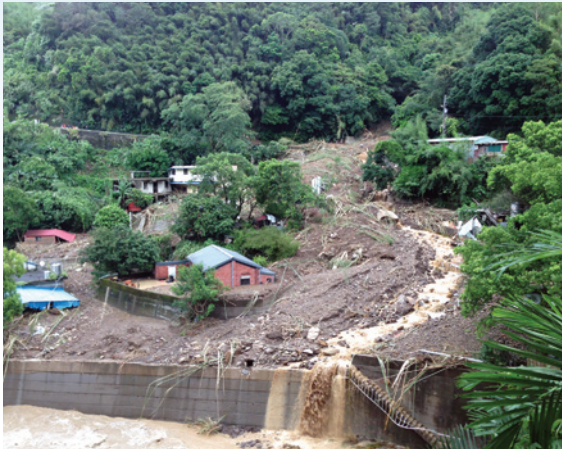
崩塌土石淹埋台七線及合流部落
