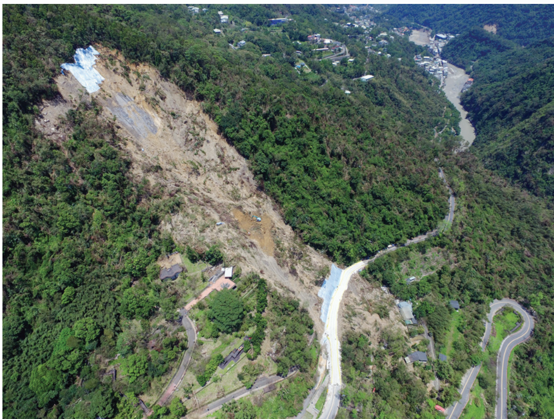
圖3-49 義勇公園大崩塌災害現場
