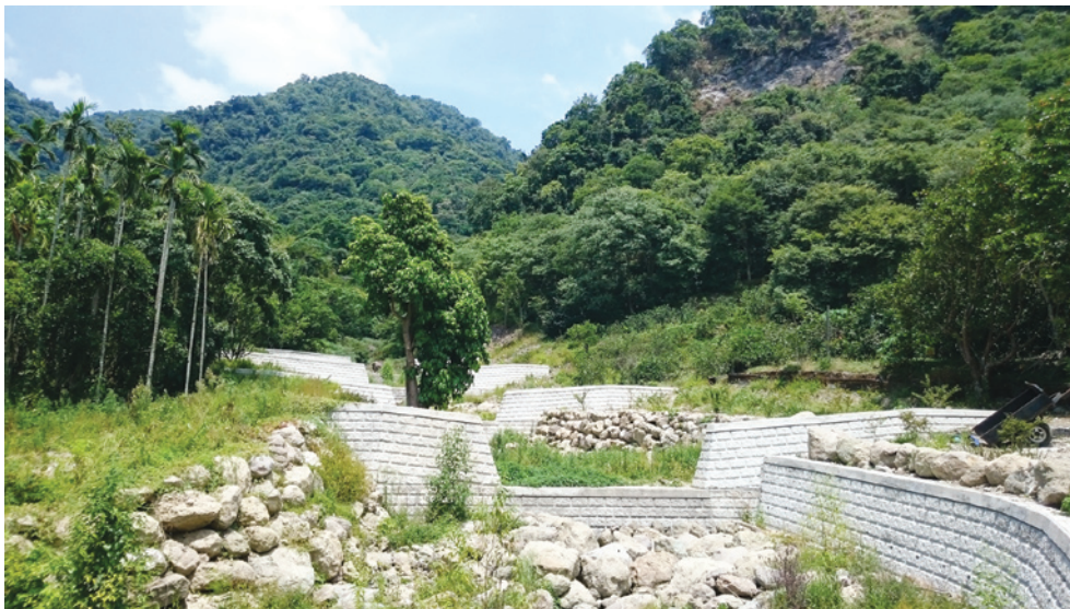
圖3-2 花蓮縣富里鄉馬加祿溪上游土砂防治工程
