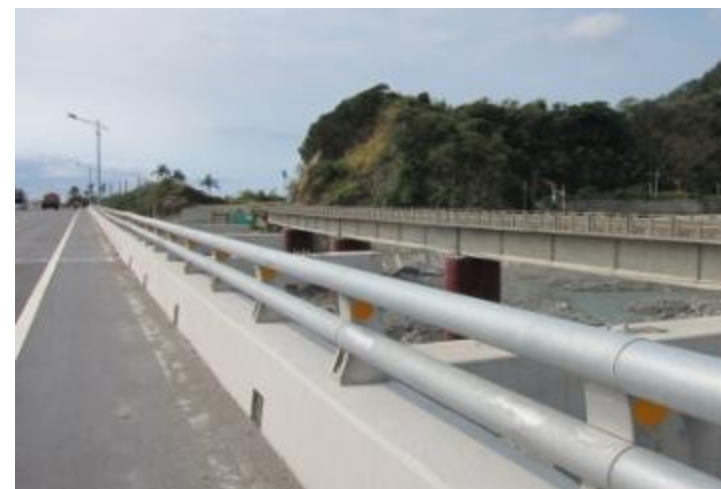
公路橋(太麻里溪)
