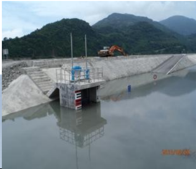
太麻里左岸二號堤防灌溉出水口
