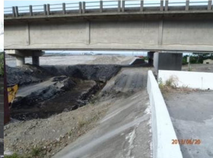
太麻里溪南太麻里橋通水狀況良好
