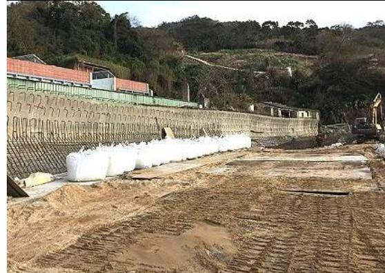
工程就既有防波堤牆加厚，防波堤頂拓寬為2公尺加強回浪效果。
