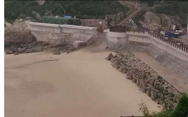
加厚既有海堤及加強基礎護坡、加寬堤頂寬度，增加反波牆之功能，除減少颱風期間越波量。
